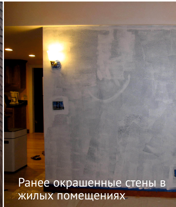
Перед нанесением цементных растворов (пол/стены/потолок)
